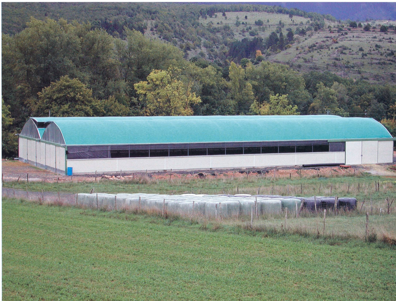
L'étable Multi-Chapelle se compose d'une structure métallique porteuse et d'un simple revêtement de toiture. (Photo: Agroscope FAT)
