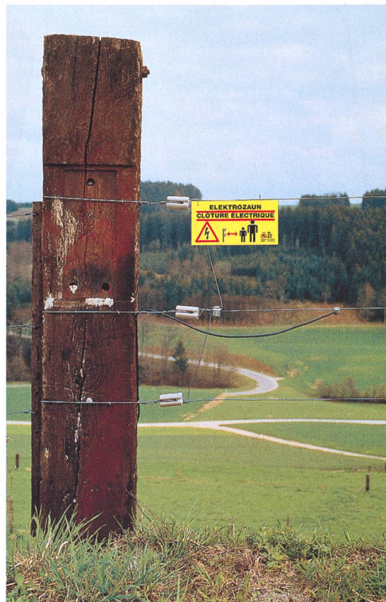
Des poteaux d'angle bien ancrés améliorent la durée de vie.
