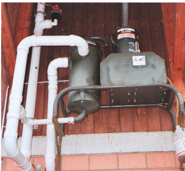
Fig. 2: Les variations de section et les coudes à 90° causent des tourbillons dans le système de conduites et des modifications de pression qui reviennent à la vitesse du son (330 m/s 2 ).
