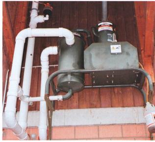
Fig. 2: Les variations de section et les coudes à 90° causent des tourbillons dans le système de conduites et des modifications de pression qui reviennent à la vitesse du son (330 m/s²).
