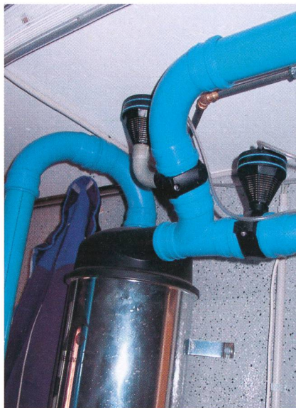
Fig. 6: Les soupapes de réglage ne doivent pas être montées à proximité de coudes, mais après un segment de stabilisation d'au moins 3 d ( d = diamètre de la conduite).
