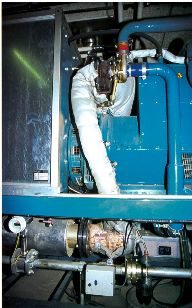
CCF, les détails: au premier plan, en haut, le turbocompresseur pour refroidir l'air de suralimentation. A l'arrière plan, le filtre à particules. La sonde de mesure qui règle l'amenée de biogaz en fonction de sa qualité. A gauche, sous le moteur, une première mondiale: un catalyseur, développé par Hug Engineering, Rätterschen, ZH (photo U. Zweifel).
