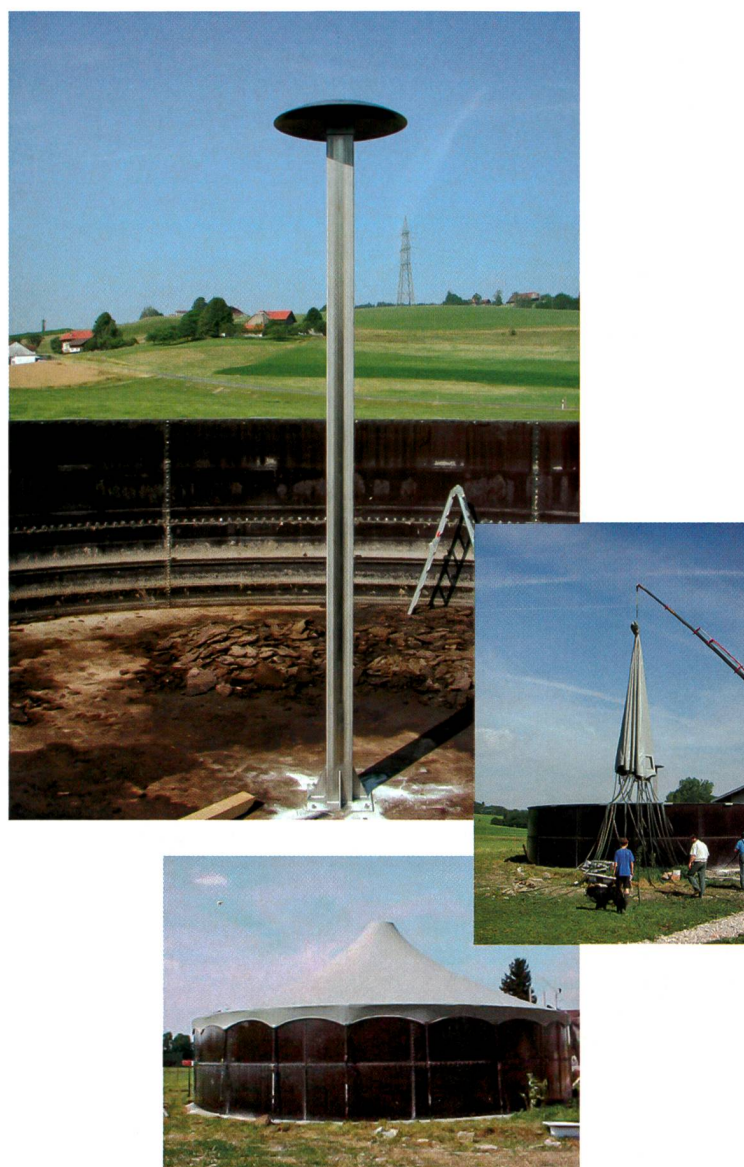
Un support en acier chromé est installé au milieu de la fosse à purin. La bâche sur mesure est fixée sur le support puis tendue au moyen de courroies sur ses parois extérieures. (Photos: FAT Tānikon)
