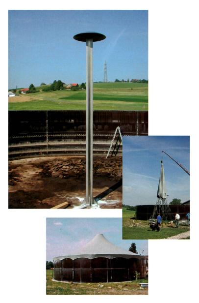
Un support en acier chromé est installé au milieu de la fosse à purin. La bâche sur mesure est fixée sur le support puis tendue au moyen de courroies sur ses parois extérieures. (Photos: FAT Tänikon)
