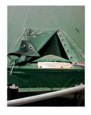
La concentration de gaz sous le toit conique peut être massive et dangereuse. Il faut équiper l'ouverture de contrôle d'un filet et toujours compter avec un risque d'explosion. (Photo: FAT Tänikon)
