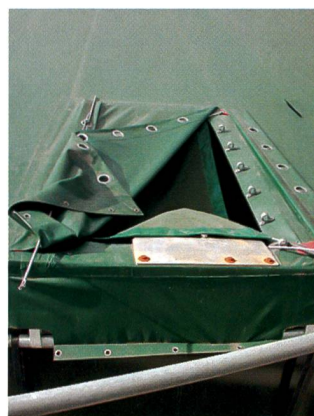
La concentration de gaz sous le toit conique peut être massive et dangereuse. Il faut équiper l'ouverture de contrôle d'un filet et toujours compter avec un risque d'explosion. (Photo: FAT Tānikon)
