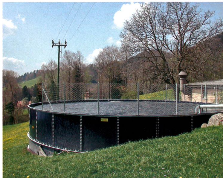
Silo ouvert avec bâche plastique perforée: les petits trous permettent à la pluie de diluer le lisier. (Photo: FAT Tänikon)
