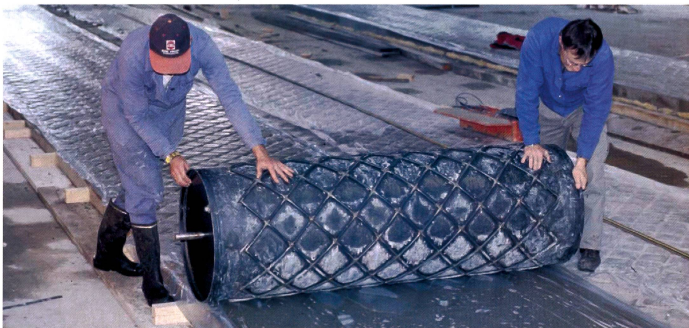
Le rouleau métallique utilisé pour le profilage doit présenter un gros diamètre. Grâce aux supports (coffrage et/ou rails de guidage), le rouleau peut rester sur la surface pendant les temps d'attente.
