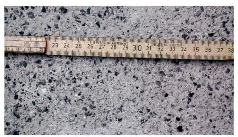
Granulé en caoutchouc intégré dans la couche de béton supérieure. Pour réduire l'usure, la technique d'évacuation du fumier doit pouvoir être utilisée de manière à ménager le revêtement.
