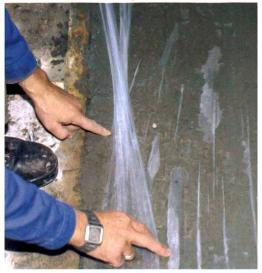
Le moment pour profiler le béton est déterminé en testant avec le doigt. Ce moment peut varier considérablement en fonction des conditions de livraison et de pose.
