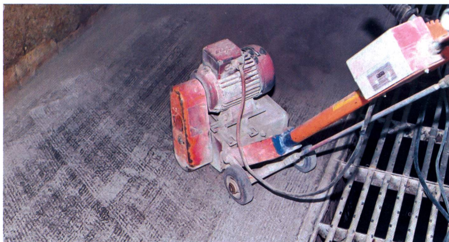
Le rétablissement de la rugosité sur toute la surface permet d'obtenir une superficie à rugosité fine. Le caractère antidérapant perdure au maximum pendant deux à trois ans, suivant la qualité du béton et les sollicitations mécaniques.
