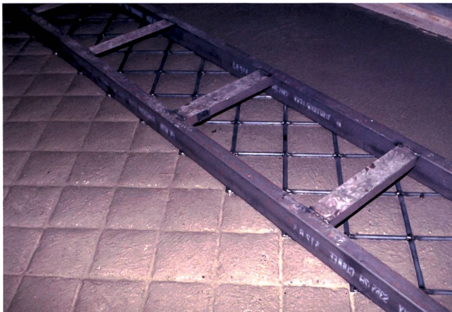
Un modèle d'empreinte ouvert permet de contrôler le travail et de bien faire coïncider l'empreinte avec la surface déjà profilée.
