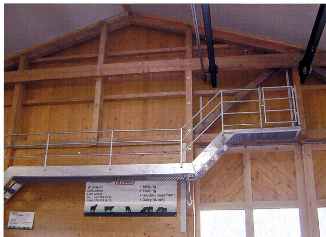
Un accès sûr au pont-roulant par des escaliers et une barrière. Après le départ du pont-roulant, l'escalier doit être fermé par une porte.
