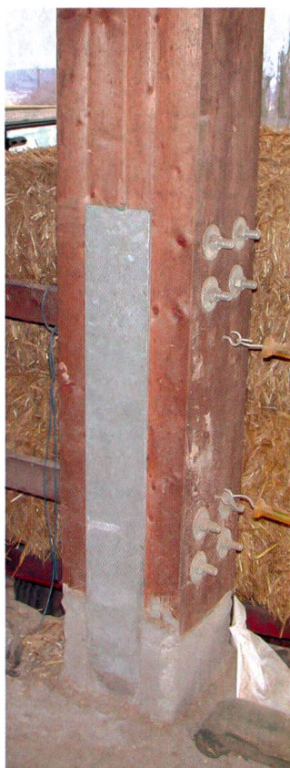
Les poteaux de bois, bien fixés dans les profils en acier permettent d'augmenter la stabilité (photo: FAT).
