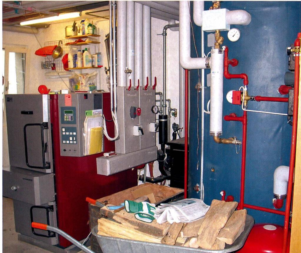
*Pour une combustion optimale des bûches dans la chaudière, le stockage de la chaleur et sa distribution dosée dans les radiateurs sont incontournables. Des améliorations, de nouvelles techniques de mesure et des cycles de régulation gérés électroniquement permettent aujourd'hui un fonctionnement à charge partielle entre 50 et 100% offrant un rendement élevé et une combustion secondaire la plus complète possible des gaz de basse température.*
