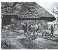
Jour de battage vers 1900: une batteuse fonctionne par un manège actionné par des chevaux. Ce système était aussi utilisé dans les mines.
