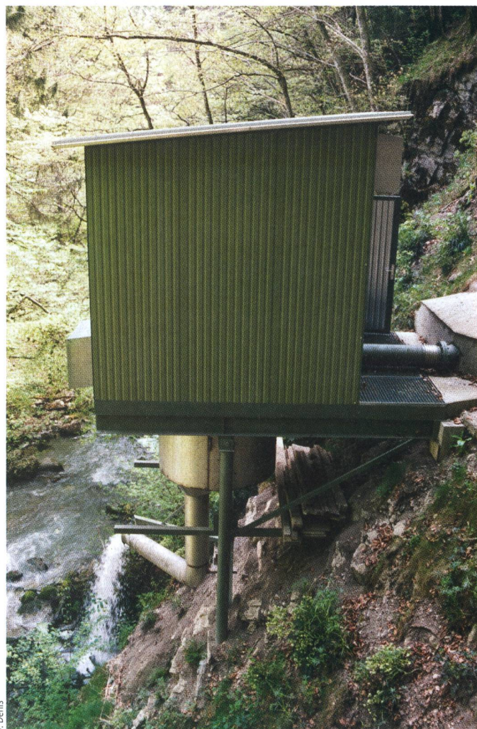
Minicentrale de la commune de Leysin: différence de niveau 83 mètres, débit 80 l/s, 57 kW. Pour ce faire, on utilise la chute située entre la STEP – station d'épuration des eaux – et le ruisseau. Denis Vincent du MHyLab est aussi convaincu que, près des STEP, on pourrait utiliser de plus petits écarts de niveaux avec les turbines Kaplan.
