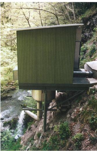
Minicentrale de la commune de Leysin: différence de niveau 83 mètres, débit 80 l/s, 57 kW. Pour ce faire, on utilise la chute située entre la STEP – station d'épuration des eaux – et le ruisseau. Denis Vincent du MHyLab est aussi convaincu que, près des STEP, on pourrait utiliser de plus petits écarts de niveaux avec les turbines Kaplan.
