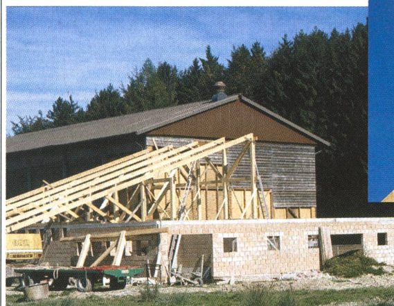
Construction des frères Stadler, Froideville, VD: Exemple d'une typologie Ariane 3: 2 + 1, un renfort à l'axe (2) et une couche de planches de chaque côté (1 et 3). Photos: J.-L. Sandoz, CBT
