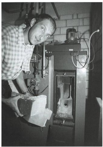
Coup d'œil dans la chambre de combustion secondaire aux parois en chamotte, de la chaudière au gaz de bois Heitzmann, modèle HS 25P.LC (35 kW). Par effet d'injection, les gaz de bois sont soufflés dans la partie postérieure avec l'air secondaire.
