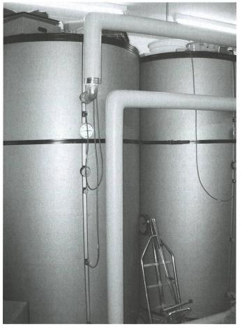
Pour le chauffage à bûches, un accumulateur à eau chaude doit être en général de 12 à 15 fois plus grand que la chaudière.
