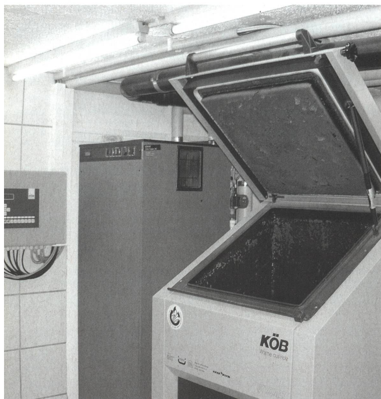
Chaudière à bois Pyromat 35 kW de Köb: la forme conique du réservoir facilite le glissement du bois vers la zone de combustion primaire.
