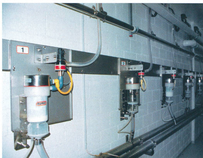
Coup d'œil dans le «subway» avec instrument de mesure pour le lait, l'électronique et les conduits.
