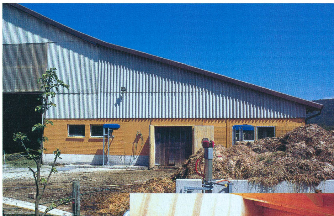
Transformation d'une étable en stabulation entravée en une étable en stabulation libre en annexant une halle de repos sur le côté.
