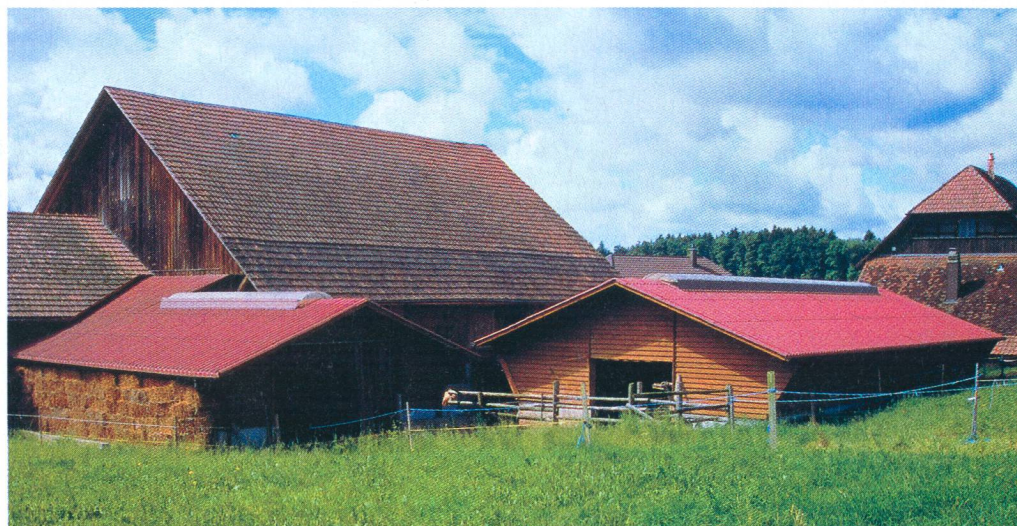
Transformation avec stabulation avec fenil surétable selon la variante 3: à droite, aire de repos, à gauche salle de traite attenante incluant un local de vêlage et les boxes pour les veaux.
