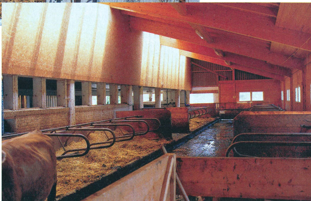
Transformation d'une étable en stabulation entravée en une étable en stabulation libre en annexant une halle de repos sur le côté.
