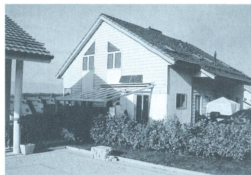
Angle nord-est de la maison, qui présente les quatre critères architecturaux de base pour être une Minergie: compacte, bien isolée, étanche, et pourvue d'un système de ventilation contrôlée avec échangeur de chaleur.
