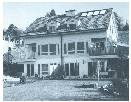
Une maison neuve à Jouxtens-Mézery/VD, divisée en deux logements absolument identiques, chacun présentant un concept de chauffage distinct (l'un aux granulés de bois, l'autre au gaz) avec un coût annuel moyen d'exploitation très inégal. Les cinq mètres carrés de capteurs solaires (en toiture, à droite) procurent de l'eau chaude sanitaire gratuite à la famille Martin de fin mars à mi-octobre.
