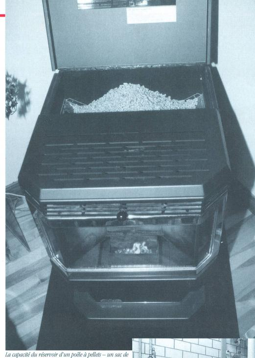
La capacité du réservoir d'un poêle à pellets — un sac de 20 kilos — correspond à une autonomie de trois, voire quatre jours de chauffage, pour une température ambiante de 19 °C. Etant donné l'homogénéité du combustible, la puissance thermique peut être réglée entre 10 et 100 %. La mise en fonction et l'arrêt de la chaudière s'effectuent sur simple pression d'un bouton.
