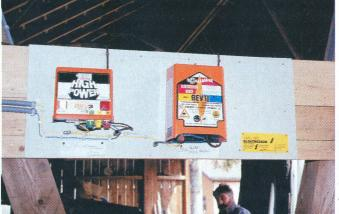
Un bon exemple d'électrificateur: la desserte et la mise à terre courent le long des bâtiments avec des câbles à haute tension et placée dans un tube ininflammable.
