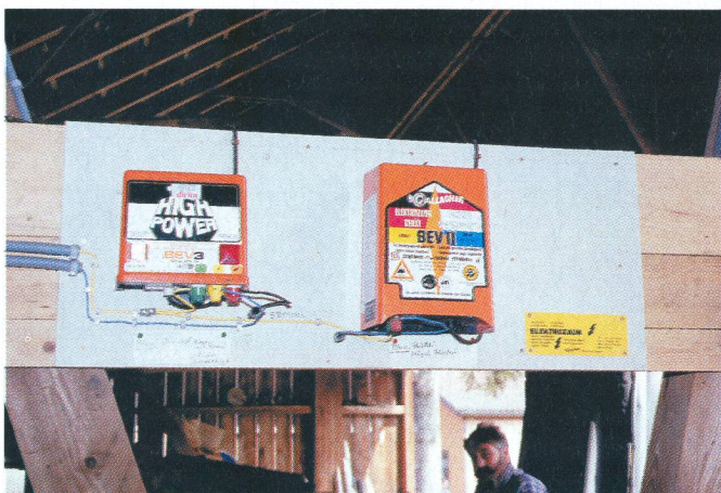
Un bon exemple d'électrificateur: la desserte et la mise à terre courent le long des bâtiments avec des câbles à haute tension et placée dans un tube ininflammable.
