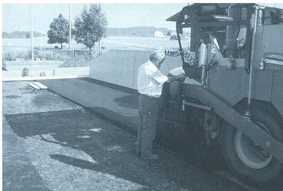
Fig. 1: Pose d'un revêtement en béton bitumineux dans un silo-couloir à la FAT.
