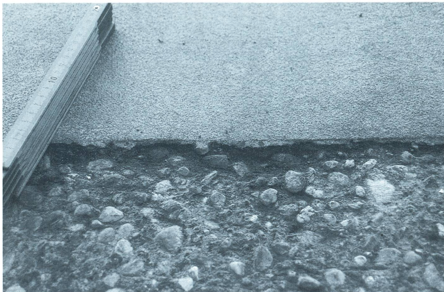
Fig. 10: Le revêtement de résine époxyde (bandes) dans le silo-couloir de la FAT est encore intact au bout de sept ans.
