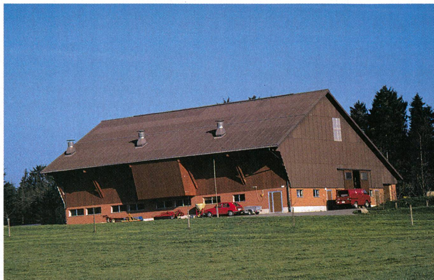
Les collecteurs solaires recouverts d'Eternit ne se remarquent pas de l'extérieur. Ils peuvent doubler l'efficacité du séchage sans apport d'autre source énergétique et limitent l'émission de bruit.
