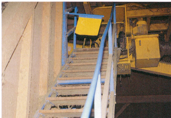
Accès au pont roulant construit par le personnel de l'IAG. Matériel: Fr. 700.-, pour différents modèles de tubes (carré 40/40/2, 40/20/2 mm, rond 3/4"), marches en sapin 700/320/33 mm. (Photo: W. Hirsiger)
