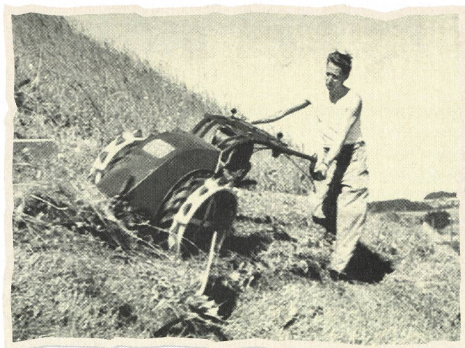
La motofaucheuse Aebi AM 52 au centre de gravité abaissé, à écartement large et mancherons de guidage à vibrations modérées est particulièrement bien adaptée au travail dans les pentes.
