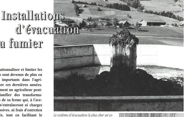
Le système d'évacuation le plus cher est celui combinant le va-et-vient et la taupinière. Le piston qui pousse le fumier sur la fumière est onéreux et nécessite une conduite souterraine très conséquente. C'est pourquoi une planification attentive doit chercher à conduire le fumier directement sur la fumière avec l'évacuateur à palettes si possible.
