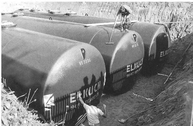
Fig. 4. Les trois citernes de stockage du méthanol, du biodiesel et de la phase glycérique sont en place.
