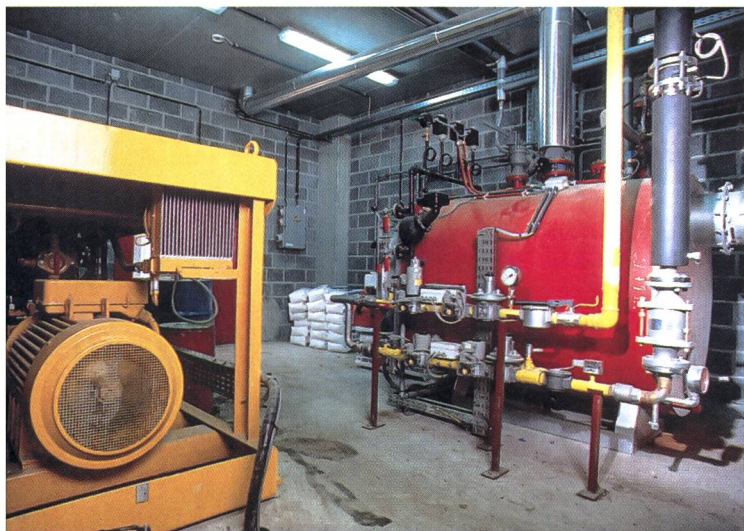
Le groupe hydraulique de la pompe de recirculation, à gauche. A droite, la chaudière à vapeur (Brecht).
