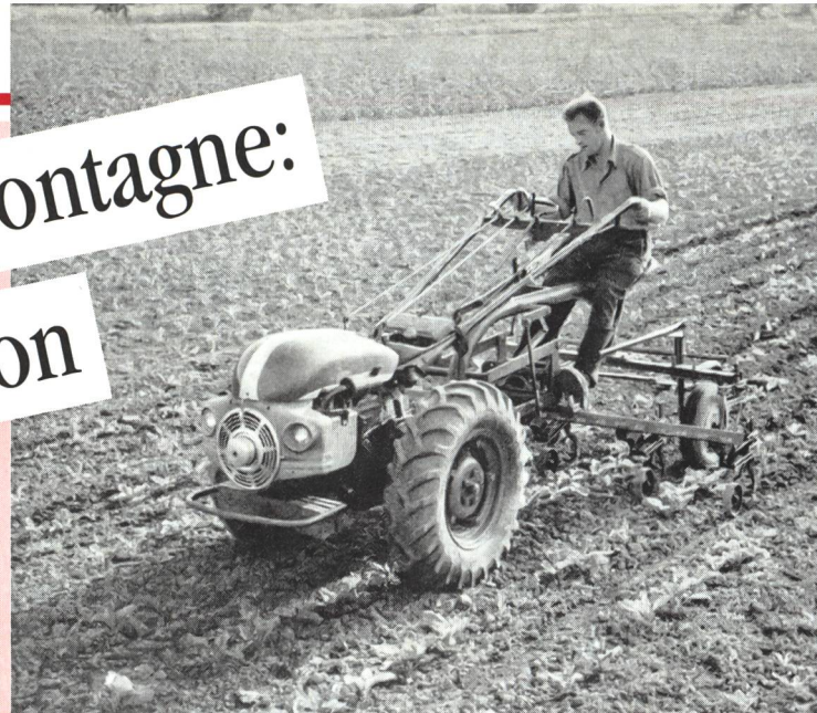
1947: Le monoaxe Bucher KT 10 sortait d'usine équipé d'une prise de force entraînant l'axe de la remorque.
