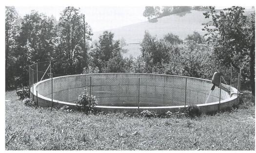
Silo à lisier bétonné sur place, avec brasseur à palettes ou a hélices.
