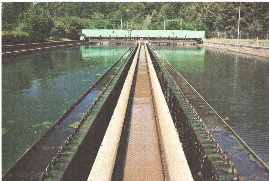
Les décanteurs secondaires ( 2 \times 1400 \text{ m}^3 ) où s'effectue la séparation des micro-organismes. Les boues décantées sont reprises continuellement au moyen d'un pont suceur et dirigées en tête des bassins d'aération ( 2 \times 1140 \text{ m}^3 ), où a lieu véritablement le traitement biologique des eaux pré-décantées.
