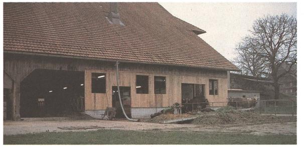
Agrandissement de l'étable: La cloison en bois munie de fenêtres largement dimensionnées permet l'intégration du volume sous l'avant-toit à l'étable.
