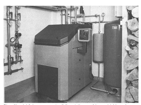
Chaudière à bûches avec porte d'alimentation supérieure et tableau de commande latéral. (photo Tiba)
