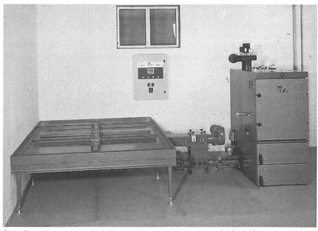
Chauffage à copeaux semi-automatique avec conteneur latéral dépourvu de paroi latérale et de couvercle. (photo Müller)
