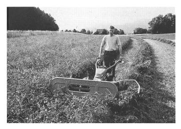
optimale au sol, confère à cette machine une aptitude supérieure en pente et se distingue par une force de soulèvement réduite au niveau du guidon. Le nouvel entraînement du dispositif de fauchage a également été breveté. Ayant été conçu sans jeu, il ne s'use pas. En liaison avec l'entraînement hydrostatique à réglage continu, la nouvelle génération d'andaineurs Rapid offre un maximum de confort et de sécurité durant l'exploitation.
