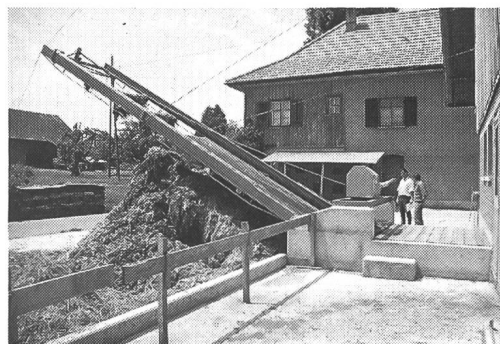
Le traîneau à fumier transporte le fumier le long de l'étable directement jusqu'à la place à fumier.
