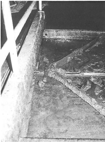
La distance «d'amorçage» relativement longue du racleur repliable nécessite la création d'une place de stationnement spéciale.
