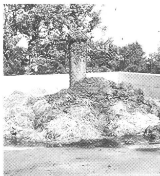
L'évacuateur à taupinière est une installation plutôt onéreuse qui présente l'avantage de surmonter des distances ainsi que des différences de niveau importante sans difficulté et d'être insensible au gel.
