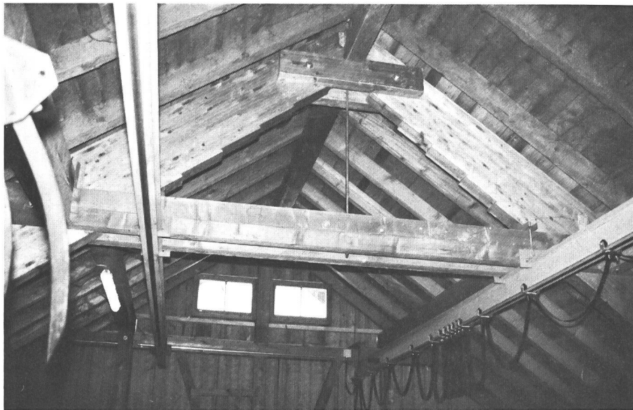
Fig. 4. Les charpentes existantes ont été remplacées par des portiques en bois lamellé collé – une procédure coûteuse.
