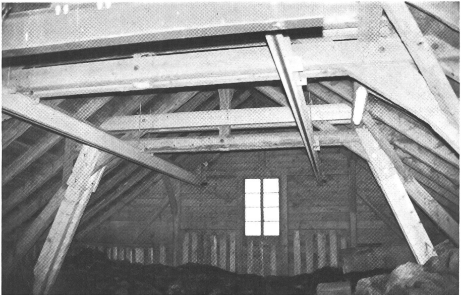
Fig. 3. Grue à griffe sur tourelle montée dans une grange existante. Un tirant supplémentaire et des contre-fiches allant jusqu'au sol servent à renforcer les charpentes. Dans un tas de foin ventilé, il faudrait entourer ces contre-fiches d'un cloisonnement afin d'éviter des pertes d'air.
