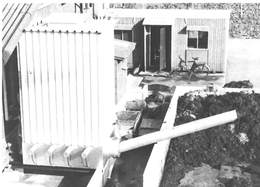
Fig. 1. Installation pilote Anacom servant à la production de biogaz à partir de fumier solide.
