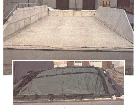
Silo d'essai de la FAT. Une paroi en béton coulé sur place avec balustrade (à gauche), l'autre en béton préfabriqué (système Traunstein). Il faut beaucoup de travail pour bien couvrir les siloscouloirs, mais ils passent, en contrepartie, pratiquement inaperçus dans le paysage.
