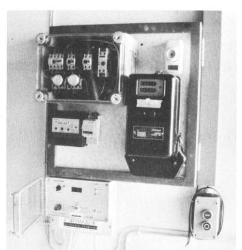
Fig. 5: Appareil de commande combiné pour le chargement et le déchargement de l'accumulateur de chaleur. Etant donné qu'un modèle standard n'était pas disponible, la FAT a fait construire un appareil spécial.
