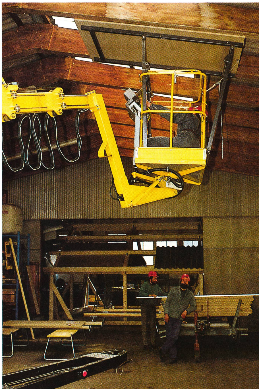
Situation réelle au cours PACER pour la construction de capteurs solaires: le transport des plaques au moyen d'un pont élévateur (au premier plan) et le montage des canaux d'aération sous tuiles, c.-à-d. sous l'éternit ondulé (au second plan).
