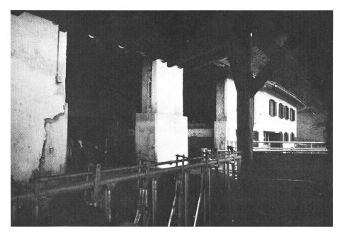
Construction «à la française»: en utilisant les anciens murs, on a conçu une étable avec des séparations pour chaque fonction requise par l'élevage laitier. Au premier plan, l'aire d'affouragement sur deux lignes, construite en bois ronds. Au second plan, on aperçoit l'étable transformée en stabulation libre avec litière profonde. Ce rural se trouve à Tomils, Domleschg (GR). Photo: SAB, Brougg
