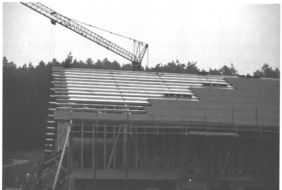
Fig. 11: Lors de construction nouvelle, il est recommandé de monter les panneaux agglomérés entre les poutres juste avant la couverture de la toiture.
