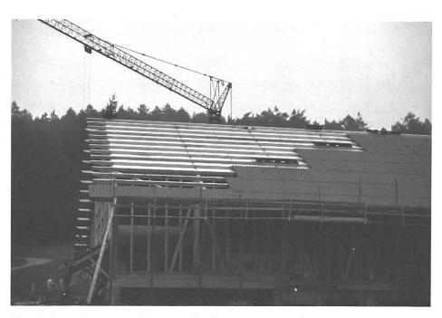
Fig. 11: Lors de construction nouvelle, il est recommandé de monter les panneaux agglomérés entre les poutres juste avant la couverture de la toiture.
