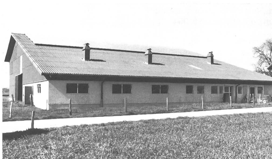
Fig. 14: Un capteur superposé sur un hangar existant et construit à l'aide de tôles d'aluminium. La deuxième couche de poutre repose directement sur le toit en éternit existant. Ce dernier est seulement percé en son milieu afin que l'air puisse couler dans le canal collecteur situé juste en dessous.
