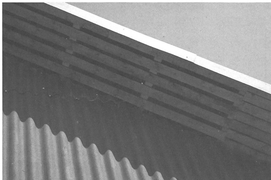
Fig. 12: Sur les côtés très exposés au vent ou pour des raisons esthétiques, il est aussi possible de monter des planches comme montré sur la photo. Il faut pourtant veiller que la largeur totale de l'ouverture soit au moins égale à la hauteur du canal.
