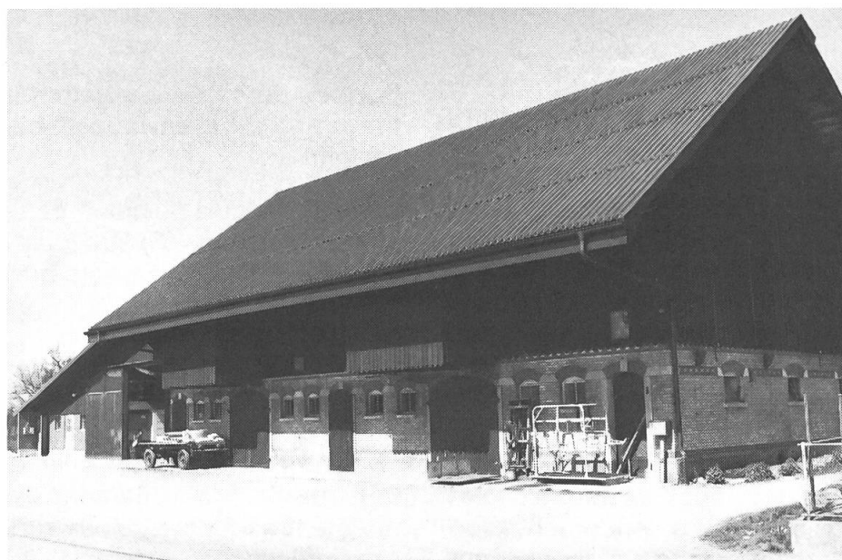
Fig. 3: Un collecteur en tôle a remplacé un ancien toit de tuile. L'entrée d'air se situe derrière le faîte du toit. Le canal collecteur conduit l'air des deux côtés, sous l'avant toit vers le ventilateur.
