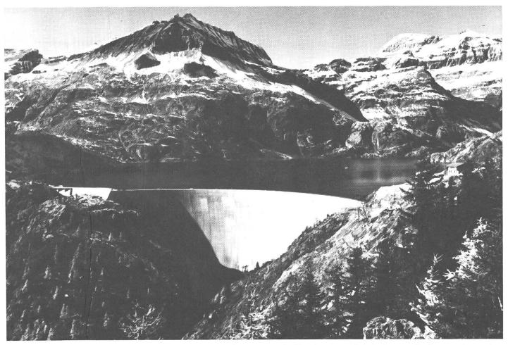
Le stockage de force hydraulique dans nos retenues alpines permet l'utilisation des précipitations estivales pour la production pendant le semestre hivernal qui constitue un goulot d'étranglement au niveau de l'approvisionnement. (Sur notre illustration, le barrage et la retenue d'Emosson en Valais, d'un volume de 225 millions de m³ d'eau.)
