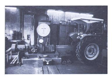
Anciennement: Le banc d'essai des moteurs de l'IMA, installé en 1958, à l'école d'agriculture de Strickhof à Zurich. Les caractéristiques principales en étaient: règle à calcul, chronomètre de verre, locaux exigus et air pollué.
