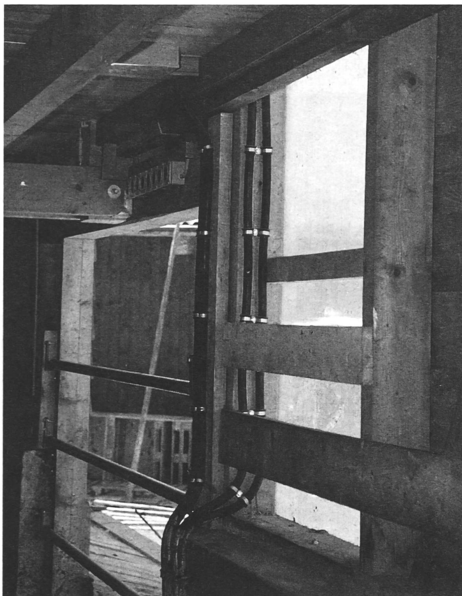
Conduites hydrauliques entre la pompe à huile et le dispositif d'entraînement pour l'évacuation du purin.
