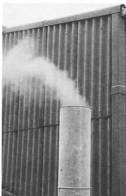
Fig. 7: Cheminée d'aération de 40 cm de diamètre (gauche). La fumée s'engouffre dans la cheminée puis est évacuée à l'extérieur (droite). Une alternative au caillebotis...
