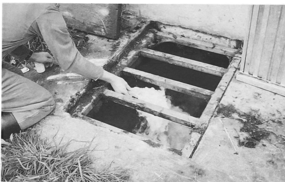
Fig. 10: Par une aération effectuée au moyen d'un ventilateur, l'air se trouve aspiré dans l'une des ouvertures...
