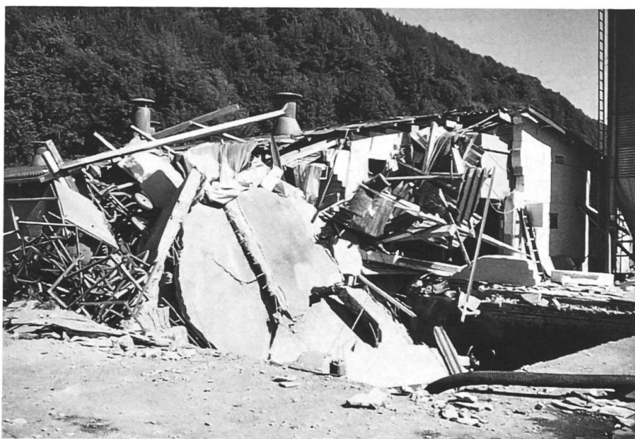
Fig. 1: ... lorsque les gaz d'une fosse à lisier explosent!
