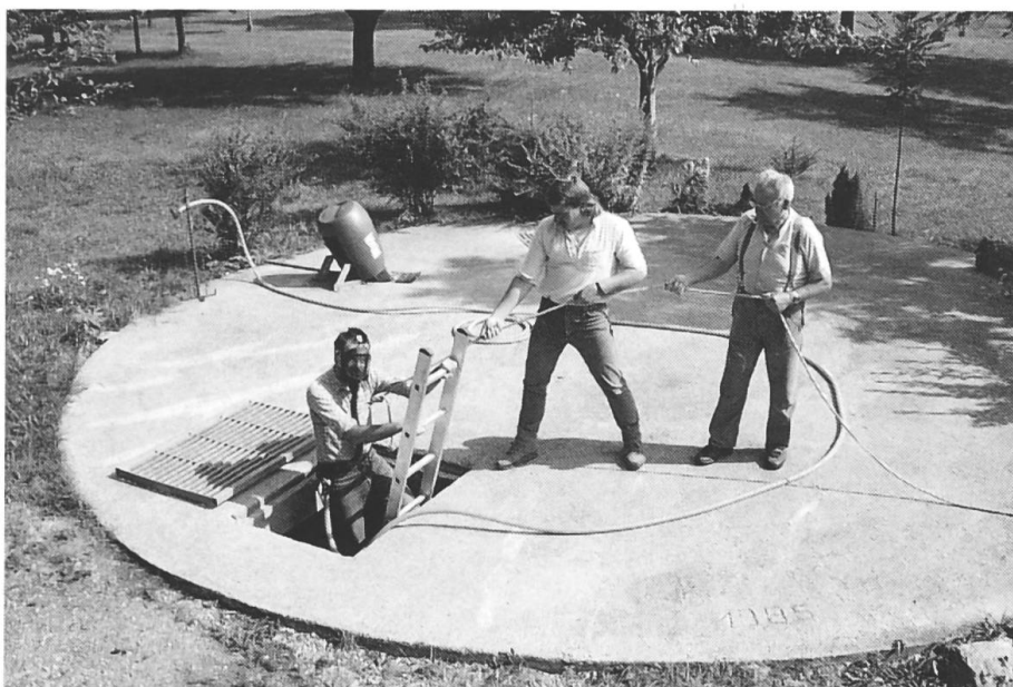
Une personne ne peut descendre dans la fosse que si elle est assurée par deux aides. Pour de petits travaux, un appareil respiratoire suffit (on peut l'obtenir dans la plupart des écoles d'agriculture). Pour de plus grands travaux (p.ex. nettoyage de la fosse), la présence d'un ventilateur est indispensable.
