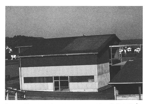
Fig. 2: Le côté gauche du toit consiste en un capteur solaire en tôle (A) de 118 m² de surface; le capteur solaire sur le côté droit, en matière synthétique (B), a une surface de 71 m² et est encadré d'une tôle de 27 m².
