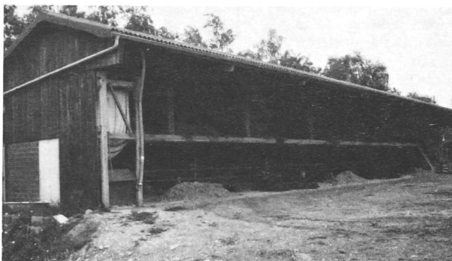
Construction économe en travail d'une «étable à front ouvert à stabulation libre, sur plan incliné» dans une exploitation d'engraissement schaffhouseoise.
