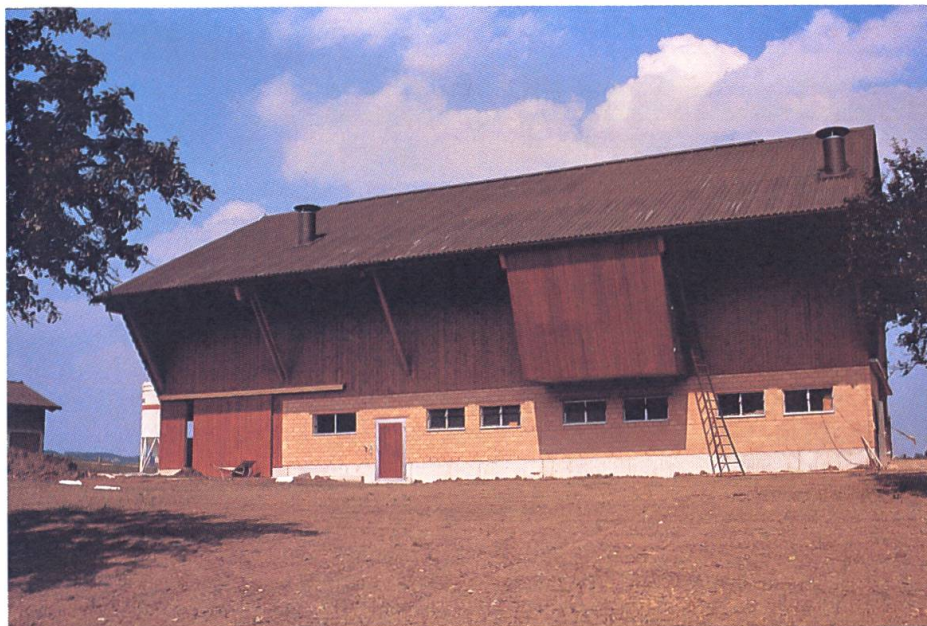
Les collecteurs solaires permettent de réduire d'un tiers environ l'utilisation d'énergie pour la ventilation du foin. De nos jours, la technique des collecteurs a fait ses preuves dans la pratique et fait partie de l'utilisation rationnelle d'énergie en agriculture.
