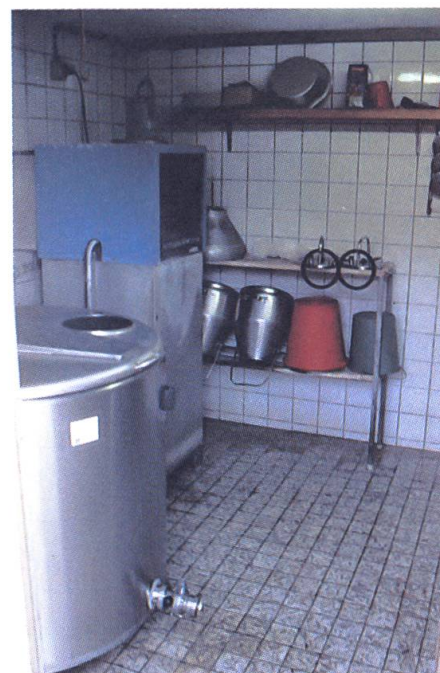
Récupération de la chaleur lors du refroidissement du lait: la chaleur libérée par la machine de refroidissement est exploitée pour le réchauffement de l'eau industrielle.
