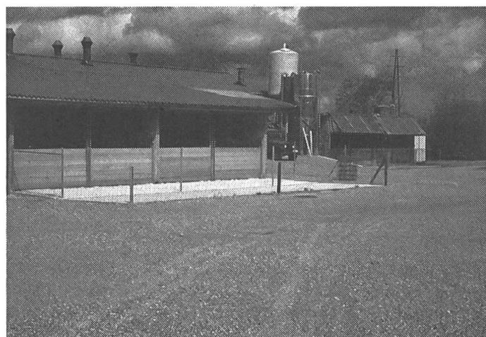
Fig. 4: Une place libre de 7 m de largeur, consolidée, devant la porcherie à front ouvert permet d'enlever le fumier dans les règles de l'art.
