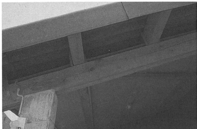
Fig. 5: L'absorption de l'air a lieu sous l'avant-toit. L'orifice d'entrée du capteur est recouvert d'un treillis à mailles fines de façon à ce que les oiseaux ne puissent pas y entrer et que la neige n'y pénètre pas. On y voit très distinctement les plaques de copeaux de bois placées entre les pannes.
