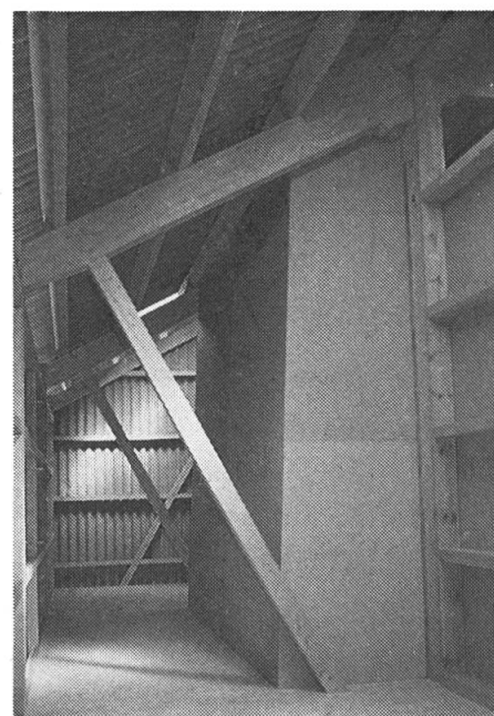
Fig. 13: Le canal d'air qui relie le canal collecteur et le ventilateur devrait être largement dimensionné.
