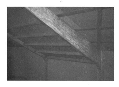
par dessus le faîte du toit il n'y a pas de ventilation par le faîte, il faut prévoir une ventilation suffisante aux pignons.
