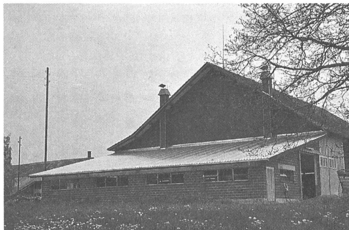
Fig. 1: Cette construction d'étable présente un capteur solaire de 190 m 2 avec un revêtement translucide. L'air entre par le bas dans le capteur et est guidé vers le haut, où il est absorbé par le ventilateur de chaque côté, au centre.
