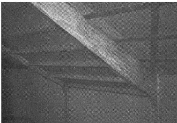
Fig. 11: Des sabots placés sur les fermes portent les poutres du canal collecteur.
