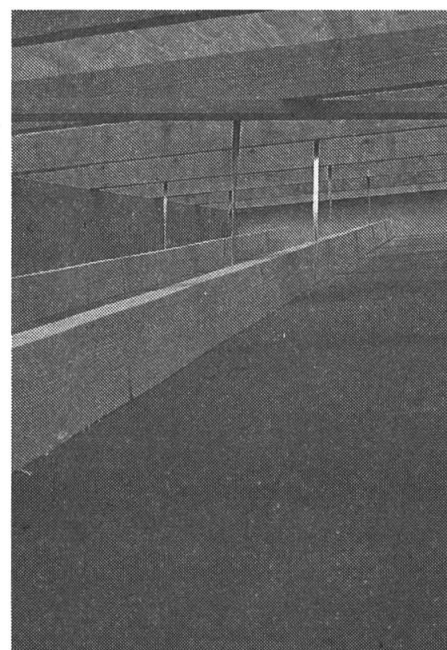
Fig. 12: Les poutres qui portent les plaques de copeaux de bois du canal collecteur sont placées dans le sens du flux d'air; elles sont fixées aux pannes, à l'aide de brides métalliques.
