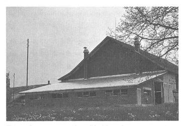
Fig. 1: Cette construction d'étable présente un capteur solaire de 190 m² avec un revêtement translucide. L'air entre par le bas dans le capteur et est guidé vers le haut, où il est absorbé par le ventilateur de chaque côté, au centre.
