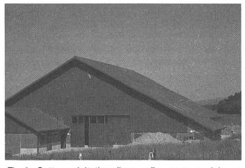
Fig. 2: Cette exploitation dispose d'un capteur solaire en Eternit, d'au moins 260 m². L'air est absorbé par un côté du faîte du toit, puis il est recueilli environ 20 m plus loin et est conduit par un canal jusqu'au ventilateur, sur le côté nord.
