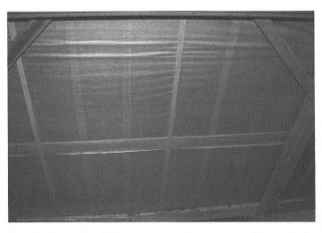
Fig. 9: Pour de vieilles constructions, ce revêtement de bâches présente une alternative avantageuse, par rapport au sous-toit par plaques de copeaux de bois. Mais il faut veiller à ce qu'il n'y ait pas de risques d'accrocs par exemple avec un pont roulant rotatif.
