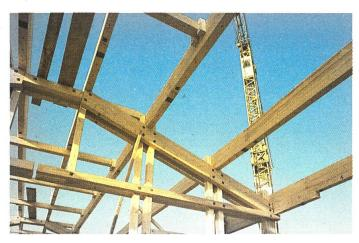
2: Sections de bois d'équarrissage assemblées mécaniquement:
