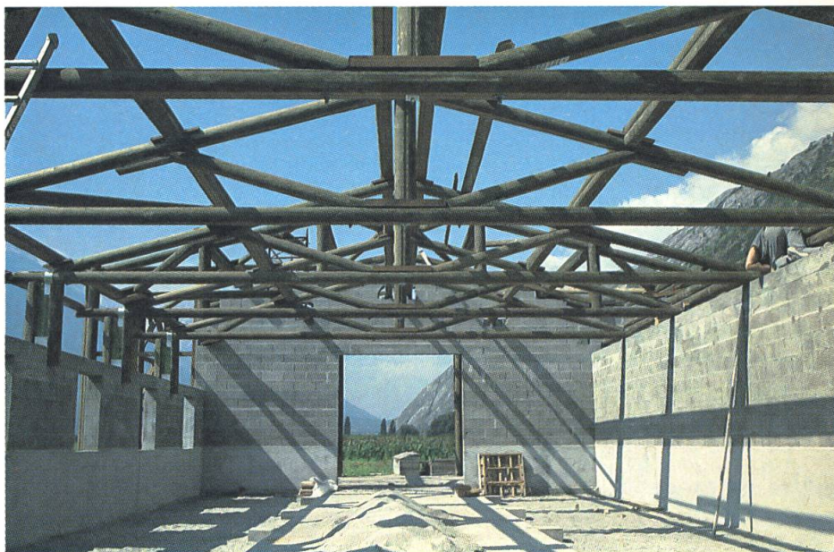
4: Etable avec grange en bois ronds (ferme principale, pannes et contreventements en bois ronds).
