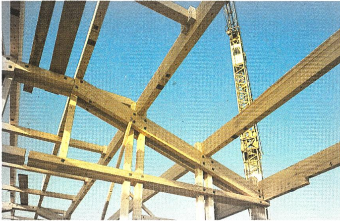
2: Sections de bois d'équarrissage assemblées mécaniquement:
