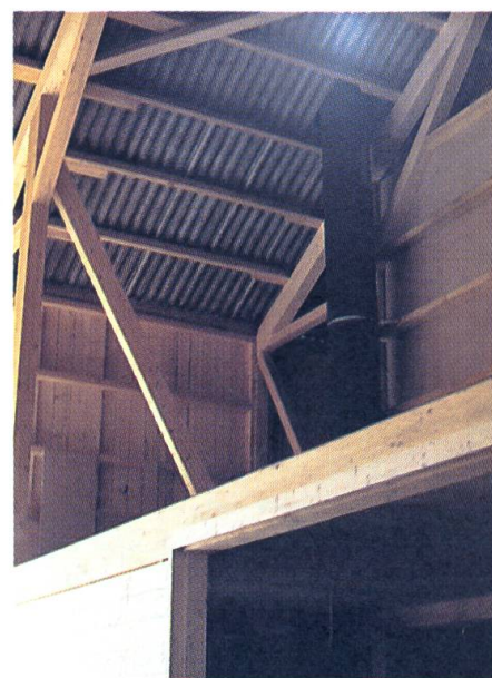
2: . . . à l'intérieur. Deux fermes avec contreventement.
