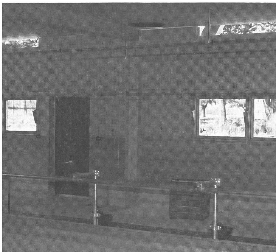
4: Fentes d'aération bien visibles. Les fenêtres à rebord en bois sont construites à hauteur des yeux.
